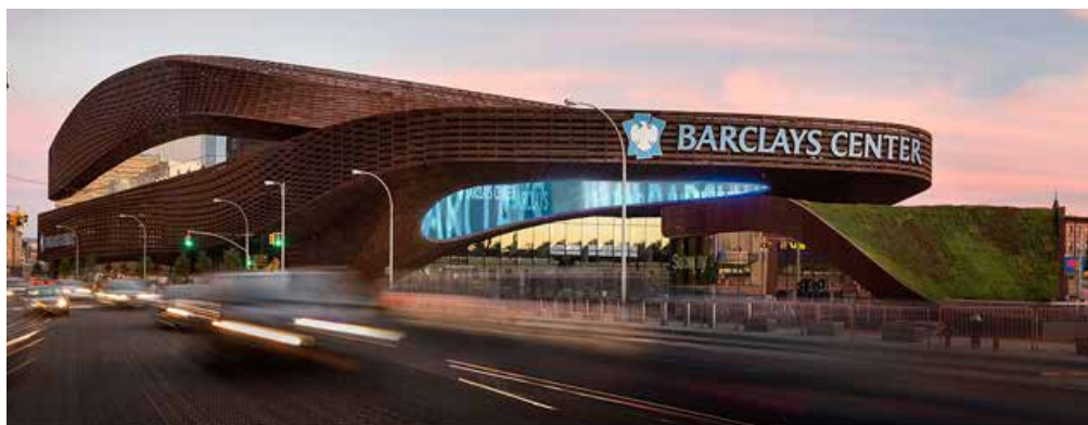
Изображение предоставлено компанией SHoP Construction
